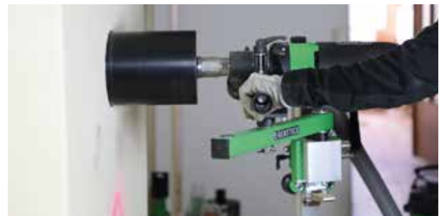
Kernbohrung für den Kaminanschluss
